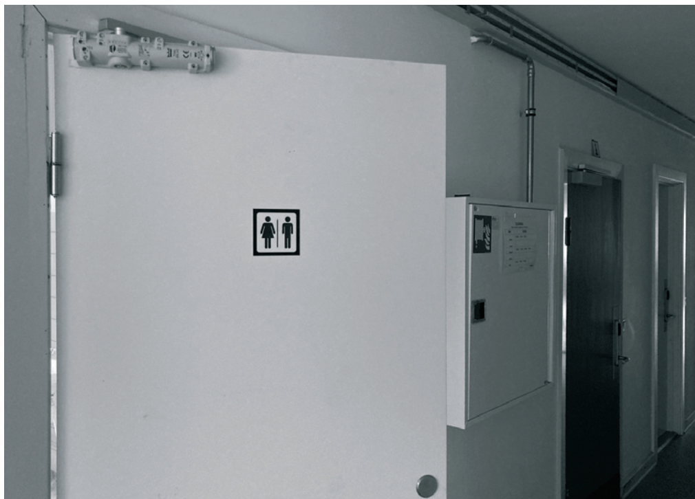
Fælles toiletter i udrejsecenter Sjælsmark, 2022.
